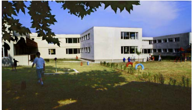
Mit der Sanierung ist die Zukunft des Kinderzentrums in Kitschevo und damit die inklusive Betreuung und Förderung von 75 Kindern gesichert.
