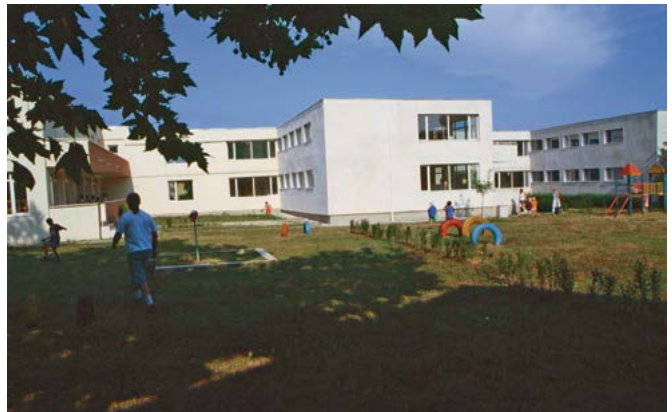
Kinderzentrum „Glaube, Hoffnung und Liebe“ in Kitschevo: Das Gebäude wird im Laufe des nächsten Jahres grundlegend saniert.
